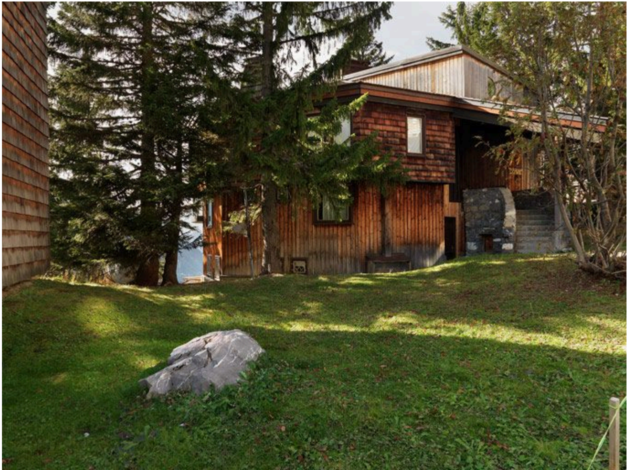
Vue générale depuis la route
