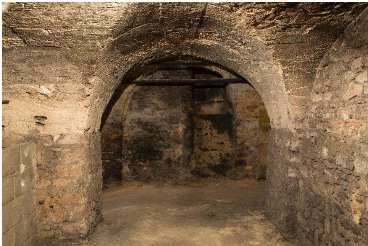
Bâtiment G. Sous-sol
