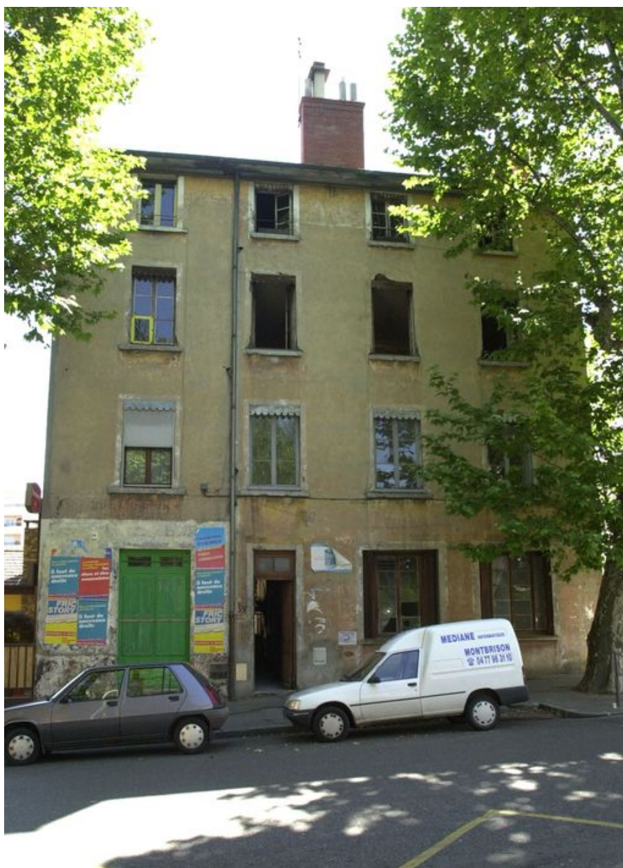
Vue de la façade sur rue
