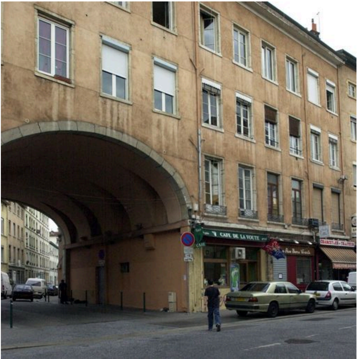
Elévation rue de la Madeleine depuis le sud-est
