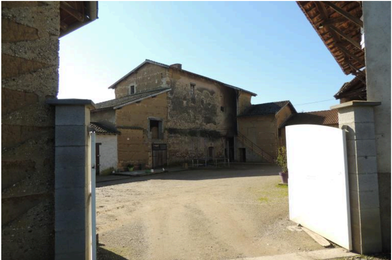
Vue intérieure de la cour : le logis, façade nord.
