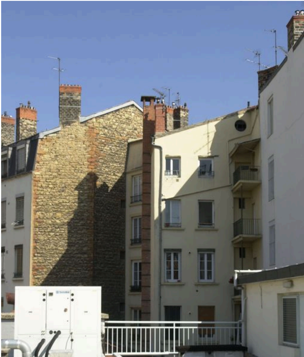
Façade postérieure de l'immeuble
