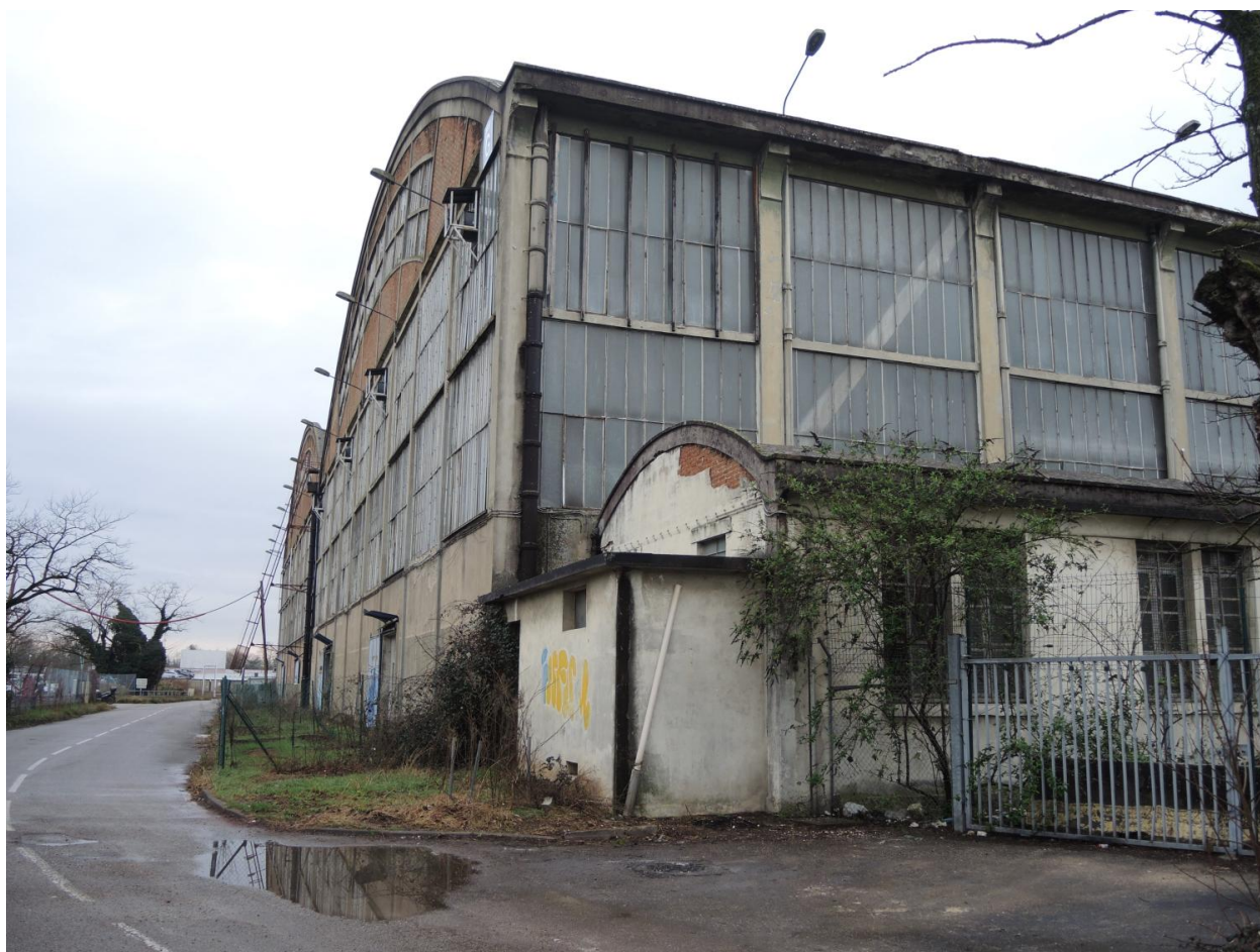
Hangar VI photo vue d'extérieur
