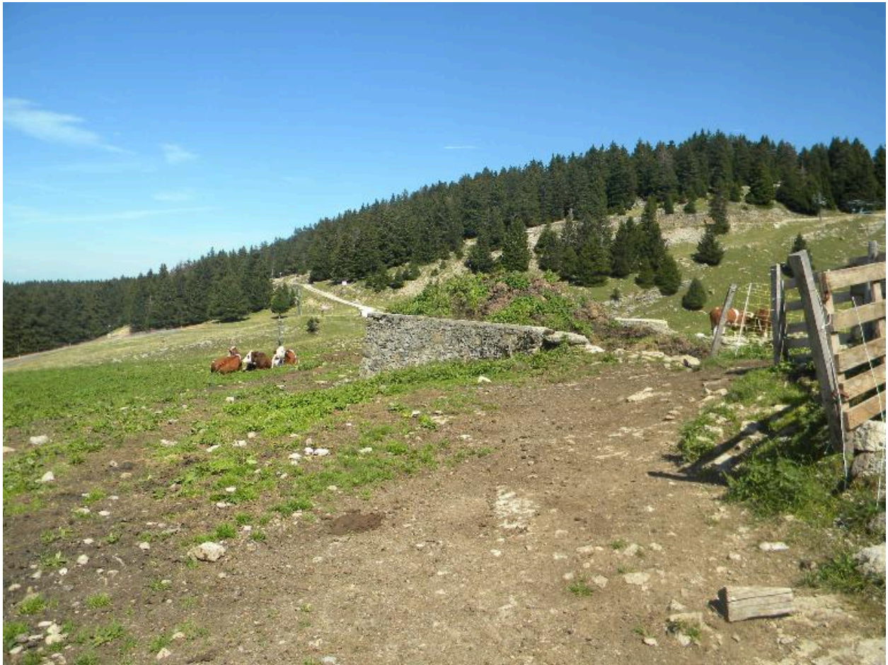
Vue d'une ancienne fosse à fumier maçonnée à l'ouest de l'étable.
