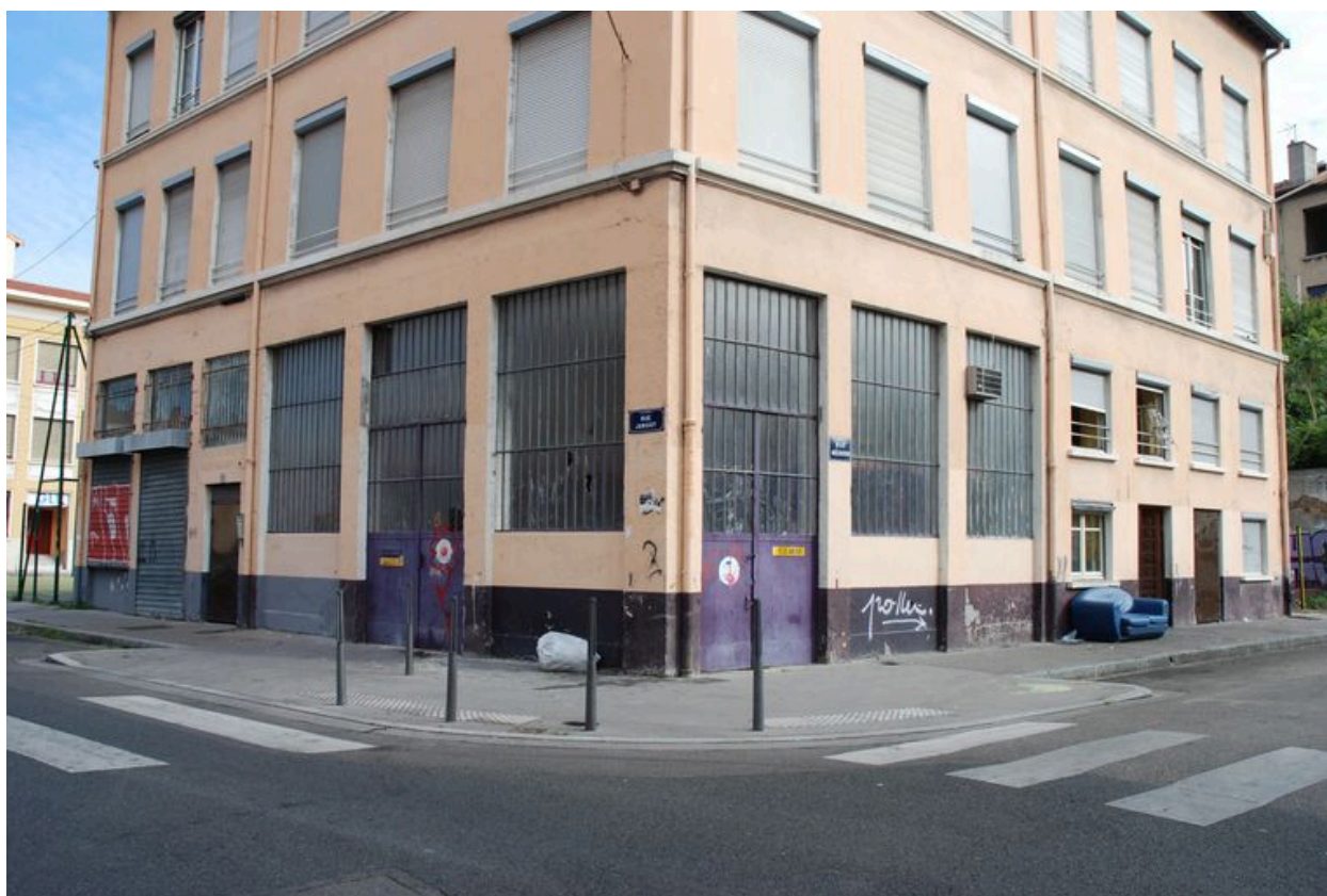
Détail des ateliers situés au rez-de-chaussée (état août 2012).
