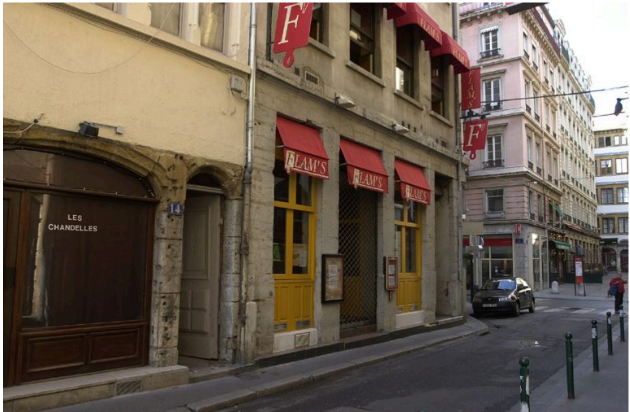
Elévation antérieure : le rez-de-chaussée
