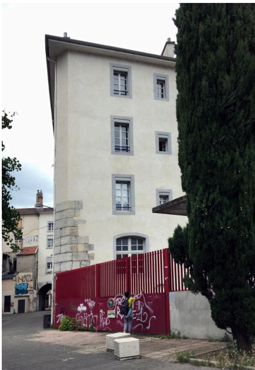
Corps de bâtiment sud-ouest (début du 19e s.) , élévation latérale nord
