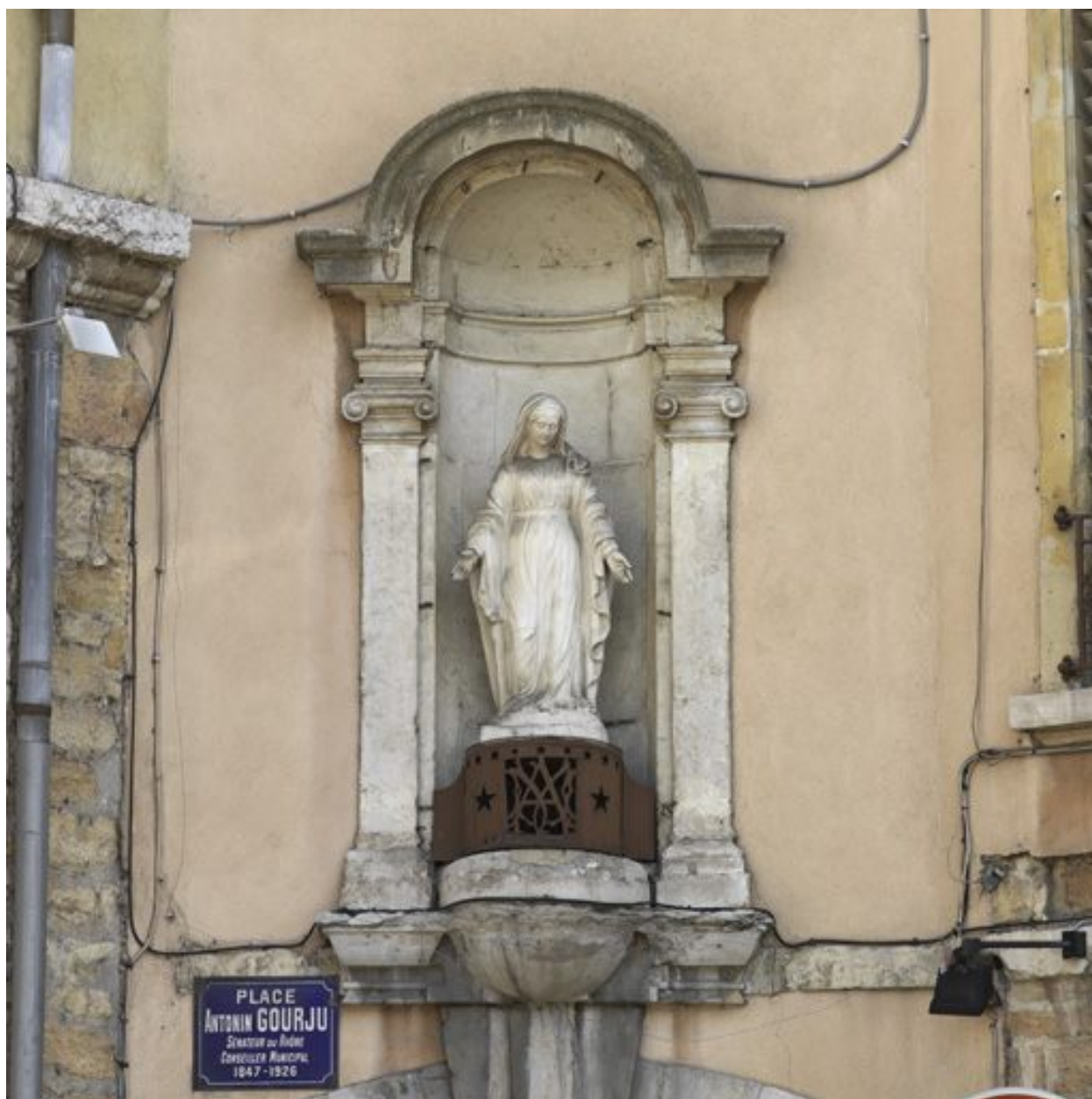
Couvent : place Antonin-Gourju, niche qui ornait l'entrée des communs du couvent
