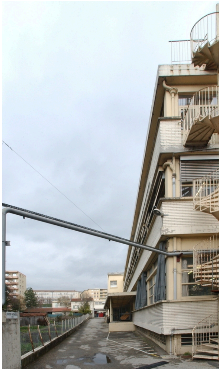
Vue extérieure des bâtiments
