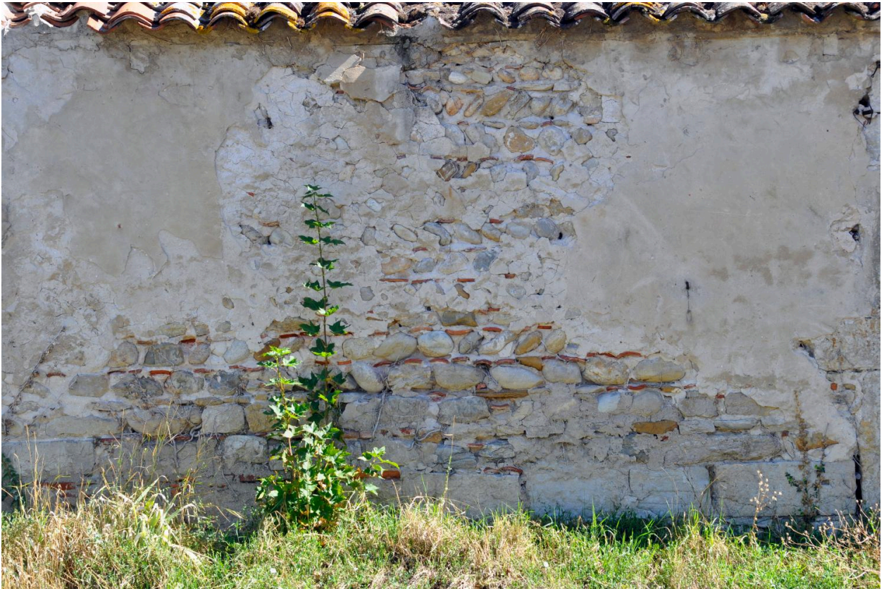
Mur de clôture à l'ouest de la maison du jardinier, maçonnerie de moellons, galets et tuiles
