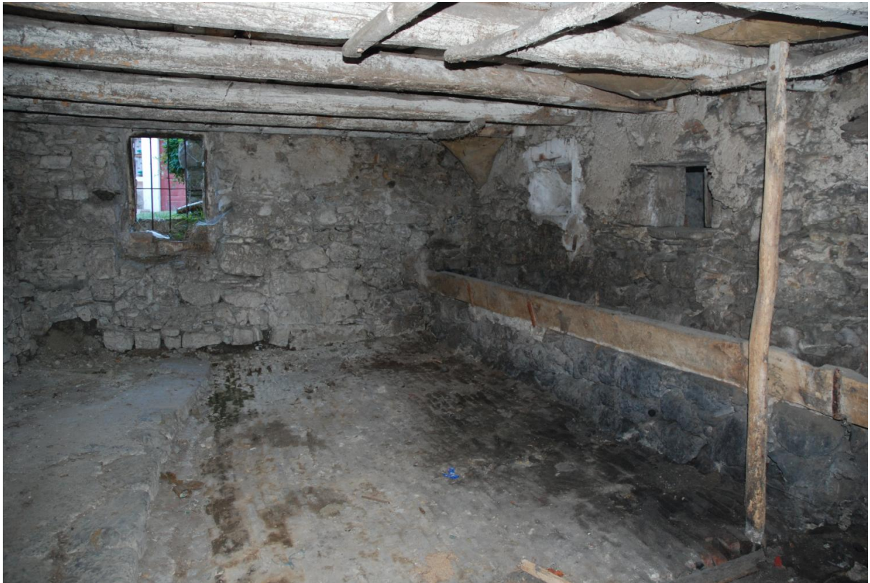
Grange-étable (2018 I1 1324), vue intérieure de l'étable.
