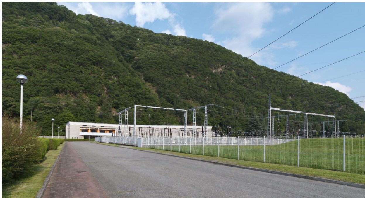
Vue éloignée du bâtiment extérieur et du poste de haute-tension.
