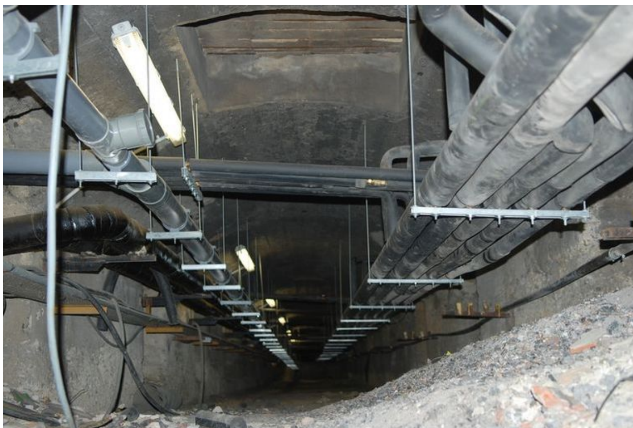
Sous-sol de l'extension de 1896-1898 de l'ancien quartier des agitées (408)
