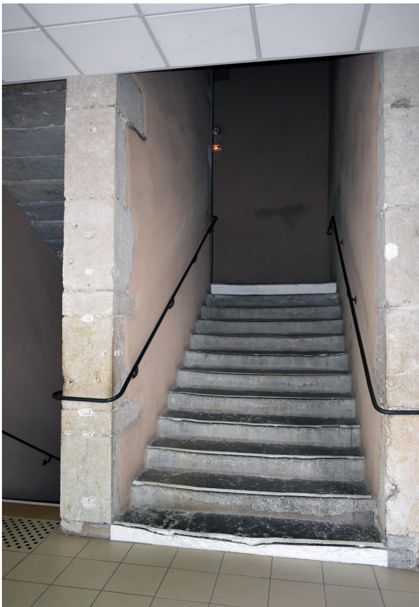
Bâtiment D : escalier A au niveau du 1er étage
