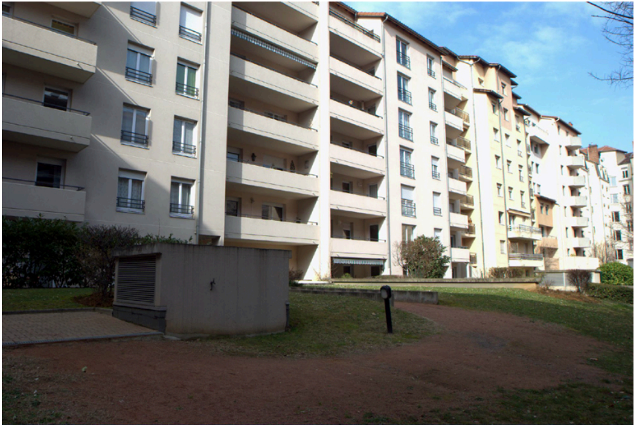
Elévation postérieure, vue partielle
