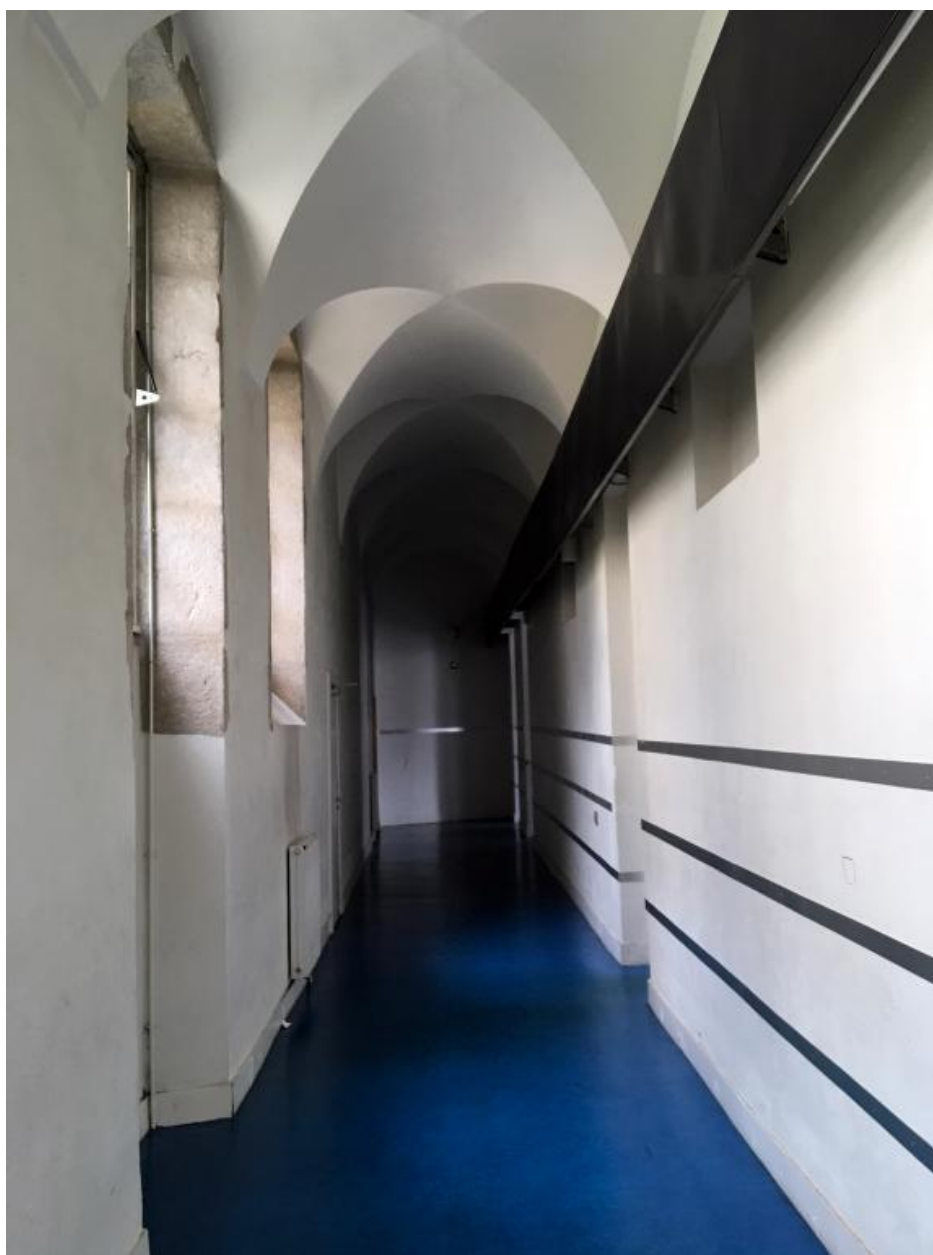
Corps de bâtiment sud : couloir du 1er étage (administration)
