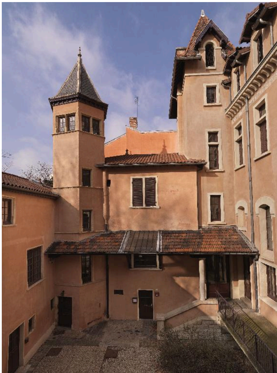
L'ancienne maison forte : vue de l'élévation nord, sur cour.
