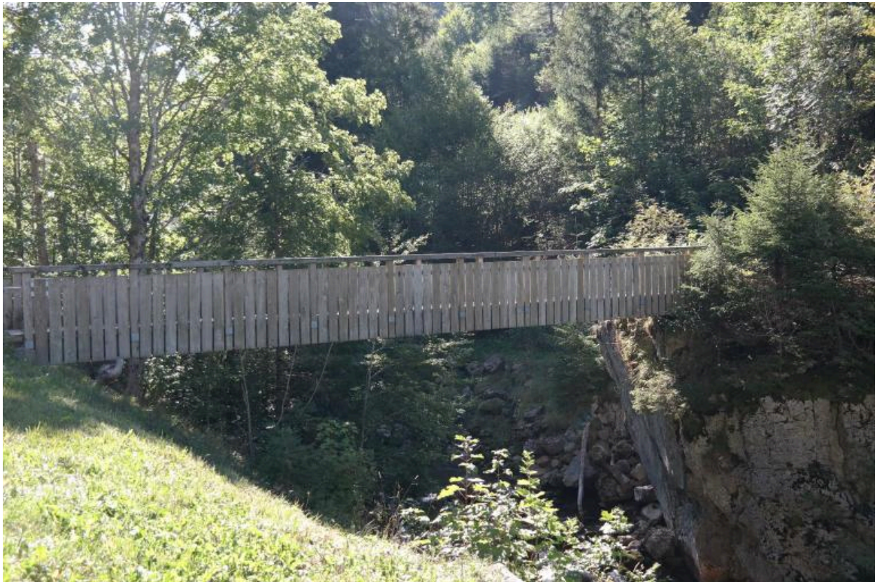
Passerelle de Porte, vue de la face aval
