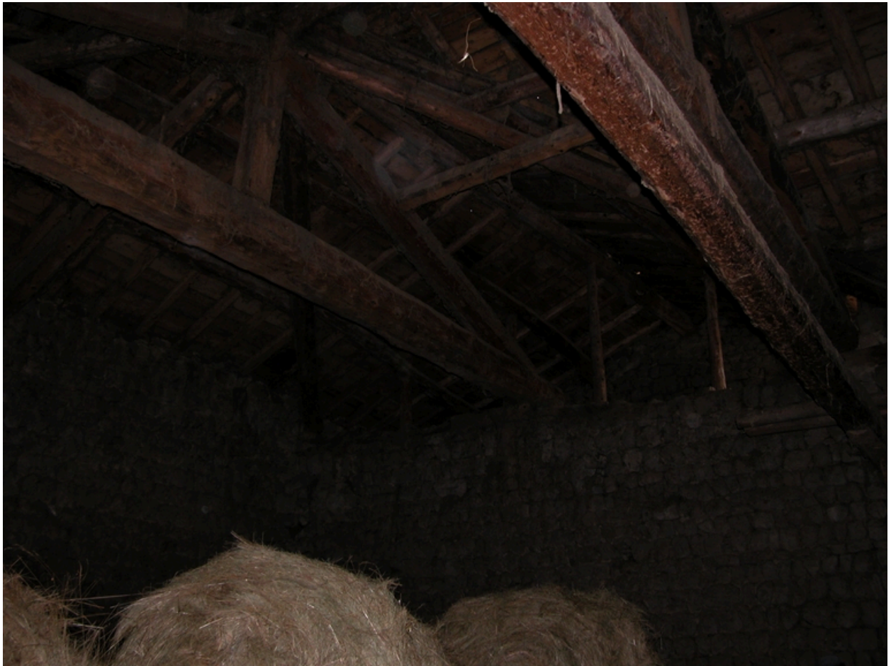
Charpente du passage couvert-cuvage.
