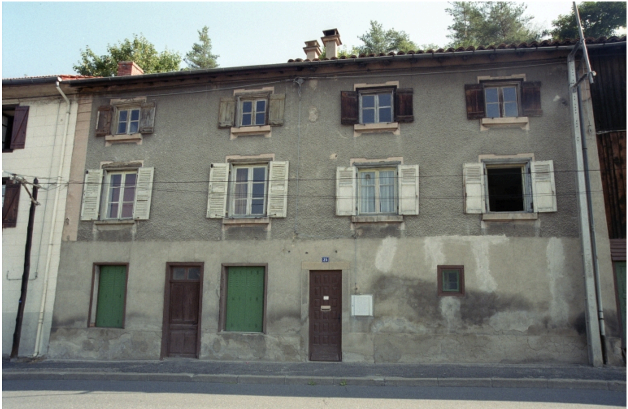
Boën, îlot 20, RN 89, 25. Vue générale de la façade sur rue.
