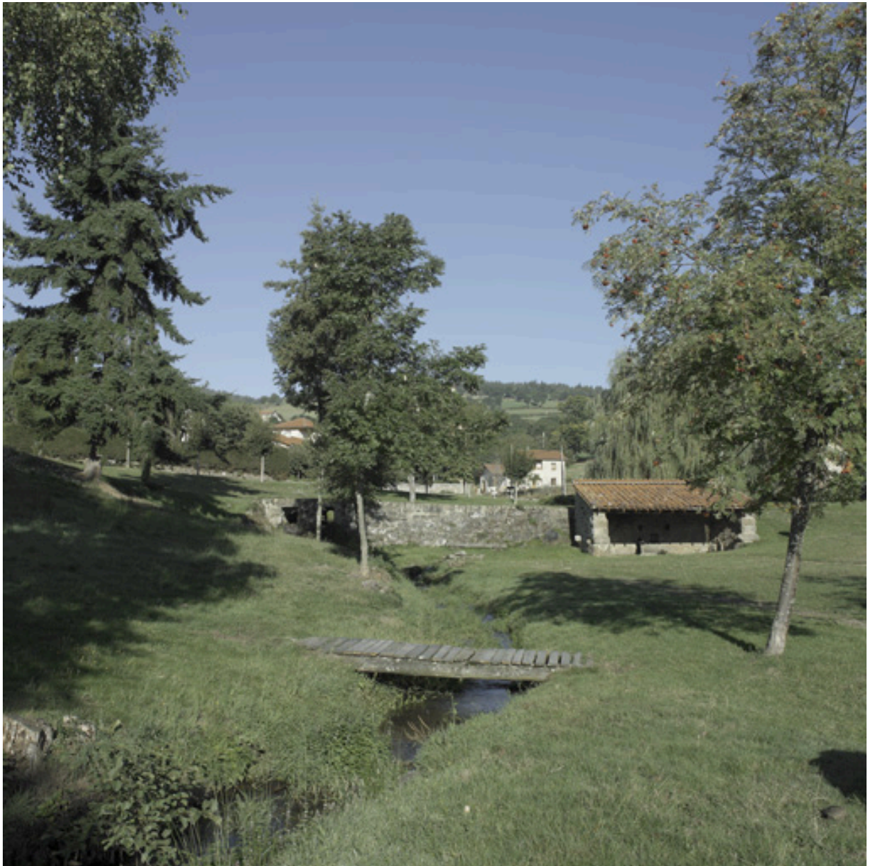
Vue de l'abreuvoir communal, de la digue et du départ du bief (avec le Probois à droite).
