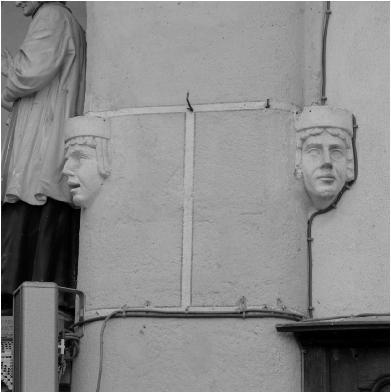
Détail de deux culots de retombée de nervures de part et d'autre du 3e pilier nord.
