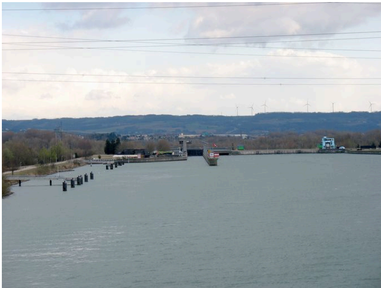
Vue générale de l'usine-écluse dans le site, côté amont
