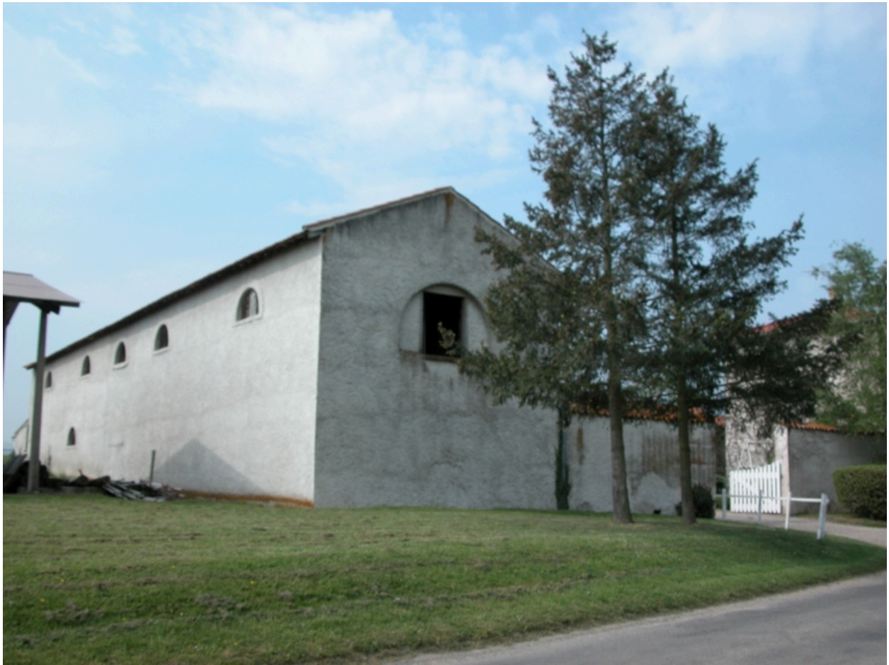
Vue du bâtiment est depuis le chemin.
