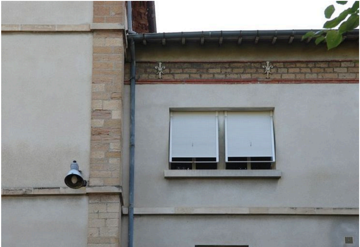
Façade ouest, détail du bandeau en briques, moellons et éléments métalliques sous la toiture
