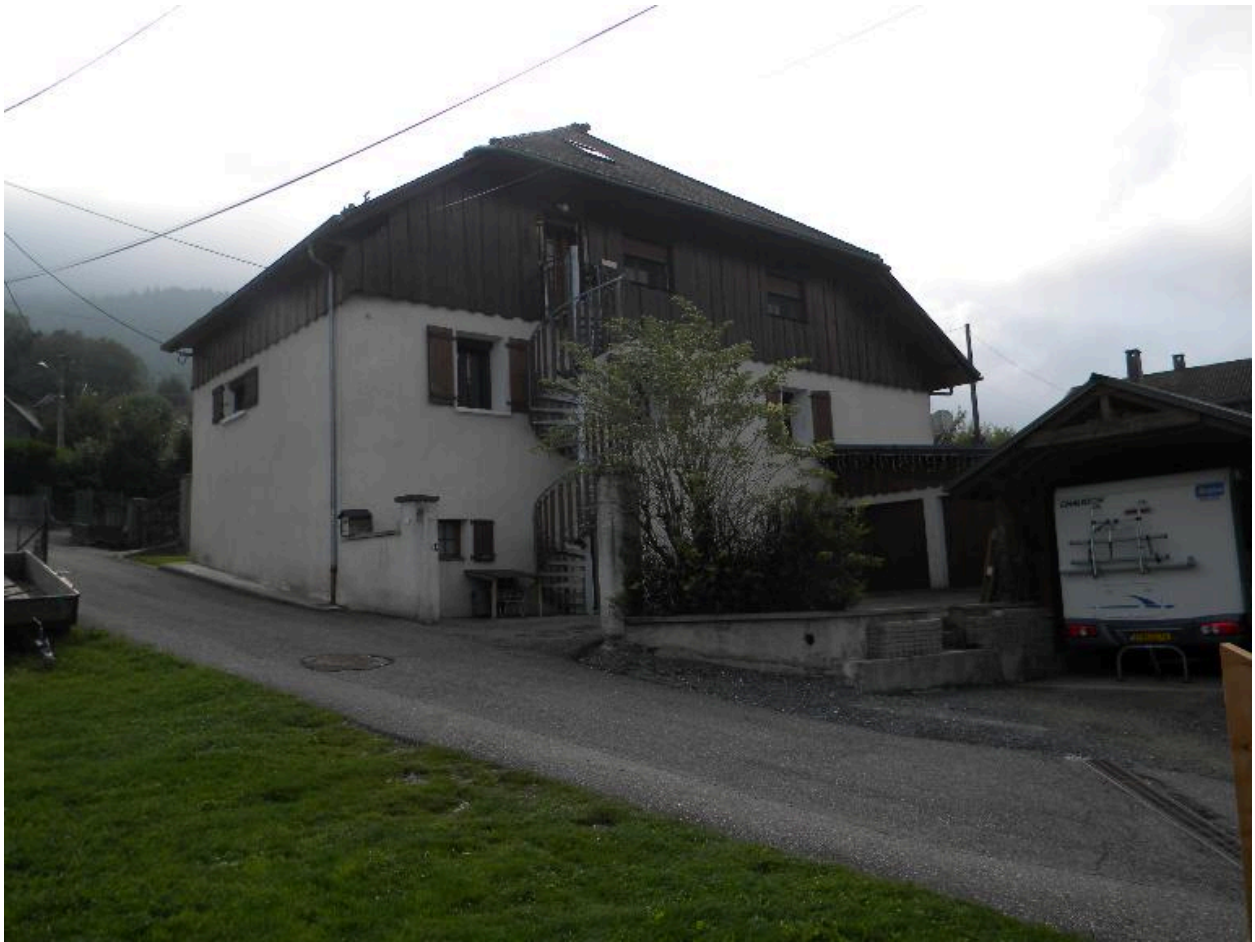
Vue d'une maison fortement modifiée (2008 E8 1174).
