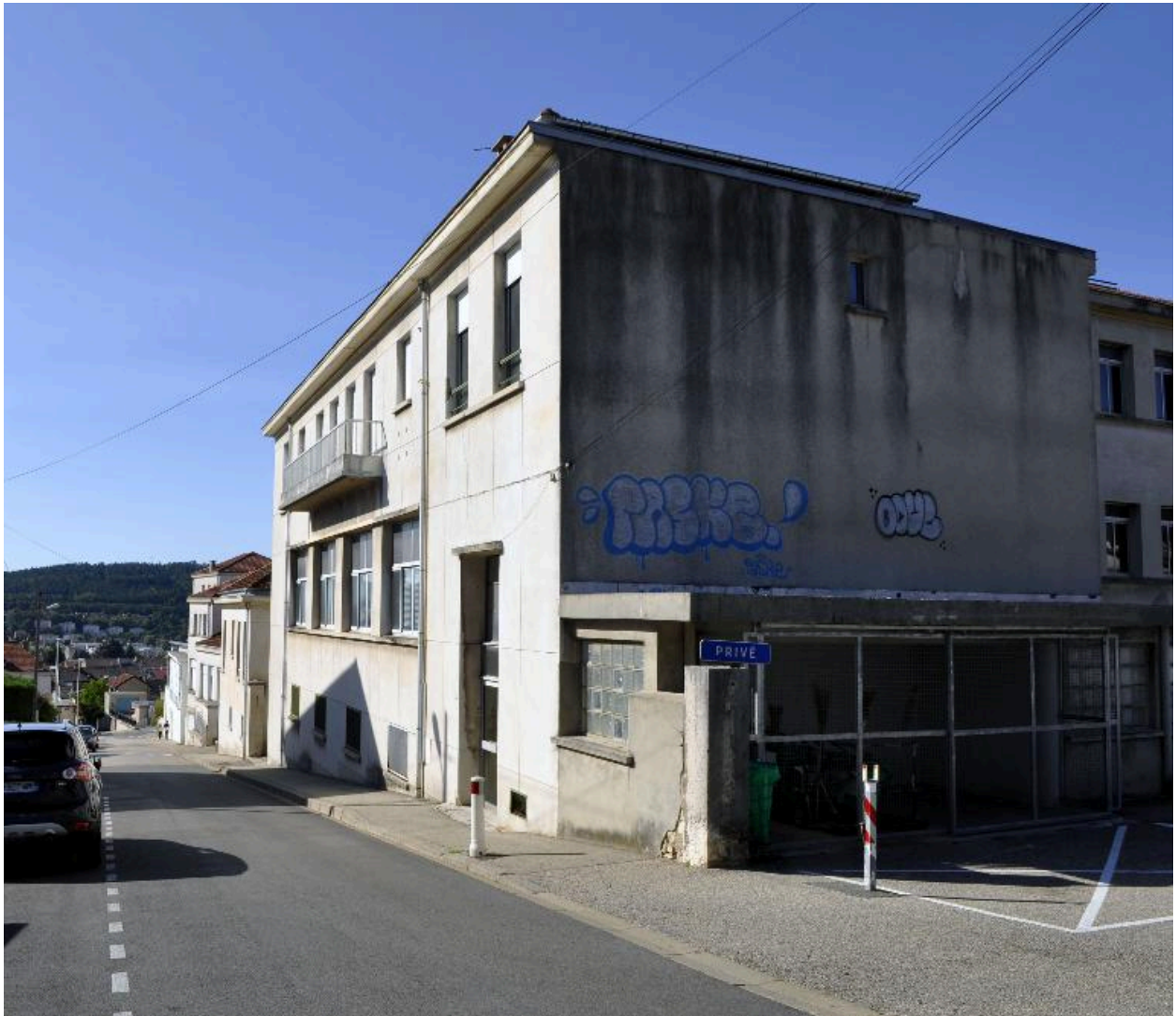
Bâtiment D, élévation ouest, depuis le sud
