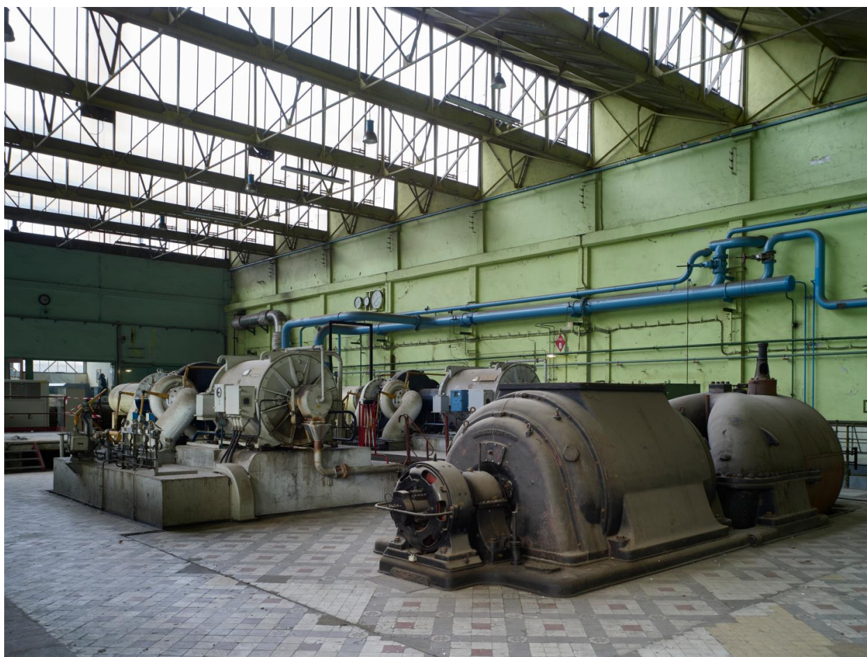
Salle des turbines de l'ancienne chaufferie, dans le bâtiment B41.
