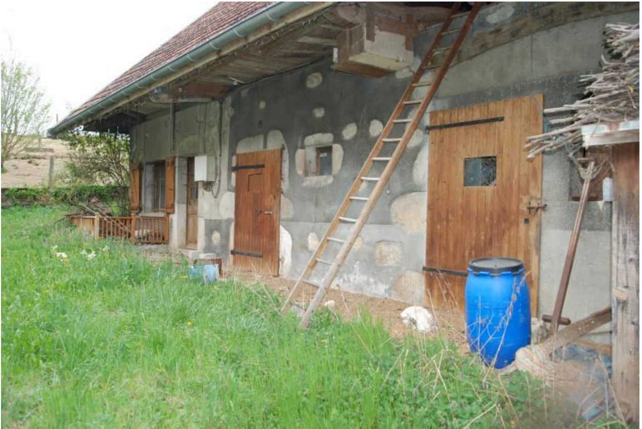
Vue d'ensemble de la façade principale de la ferme n° 504.
