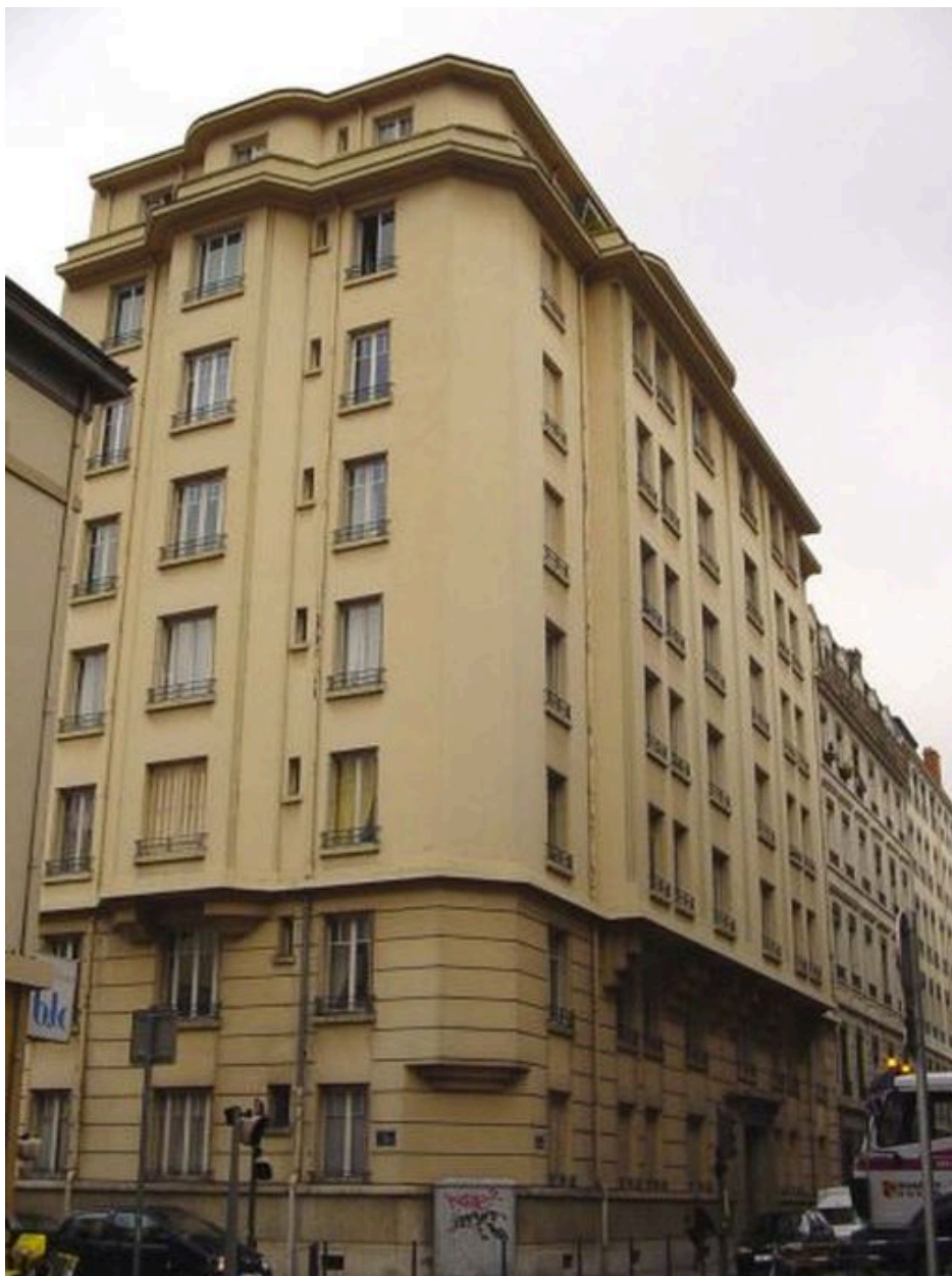
Vue générale de l'élévation
