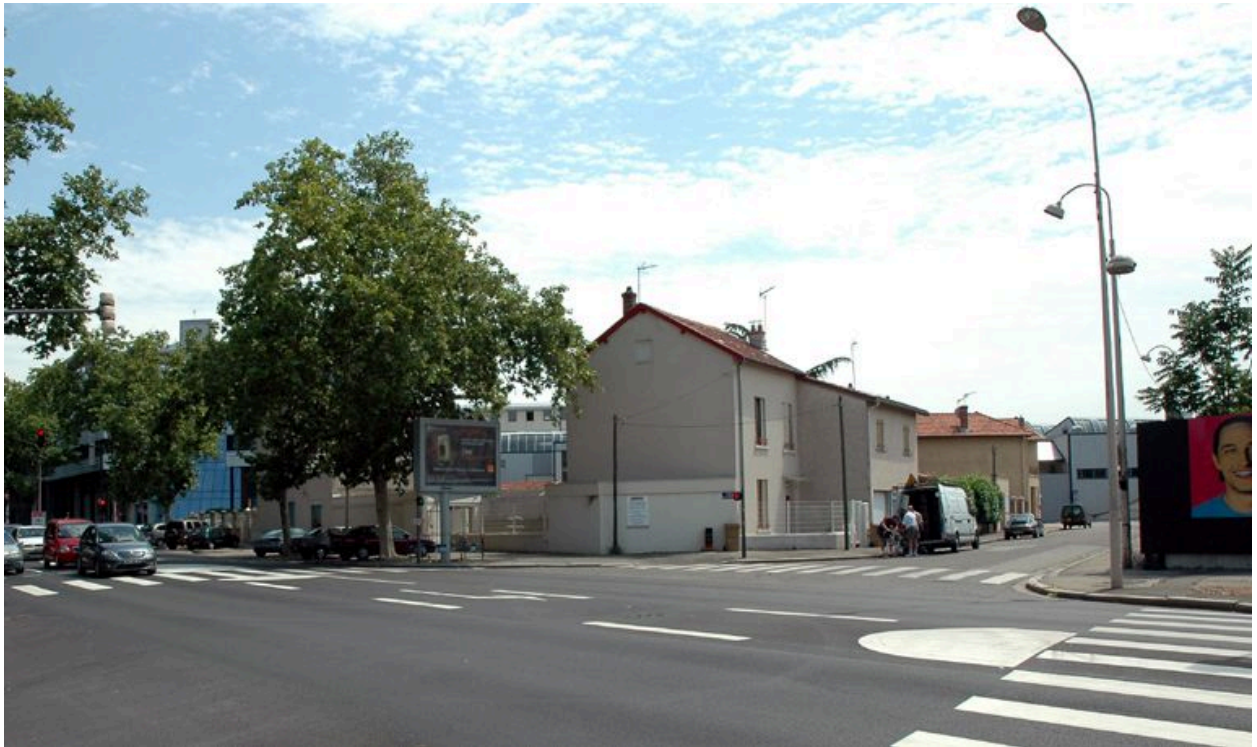
Vue de l'îlot 43 à 49 rue Edouard-Nieuport, 56 et 58 avenue Jean-Mermoz depuis le nord ouest
