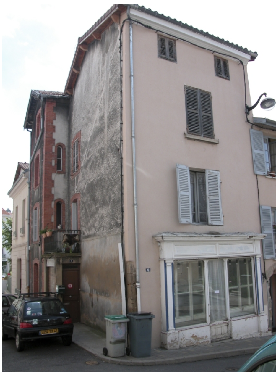
Îlot 9. Carnot (place) 06 / Vingtain (rue des). Vue générale des façades sur la place et la rue
