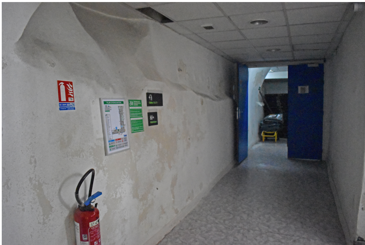
Bâtiment A, étage de soubassement : couloir desservant les anciens cuvages
