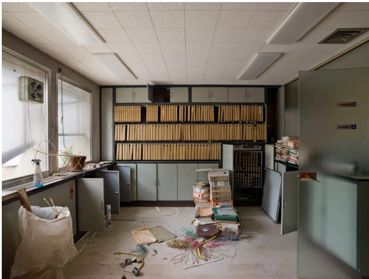
Bureaux : archives commerciales au sol
