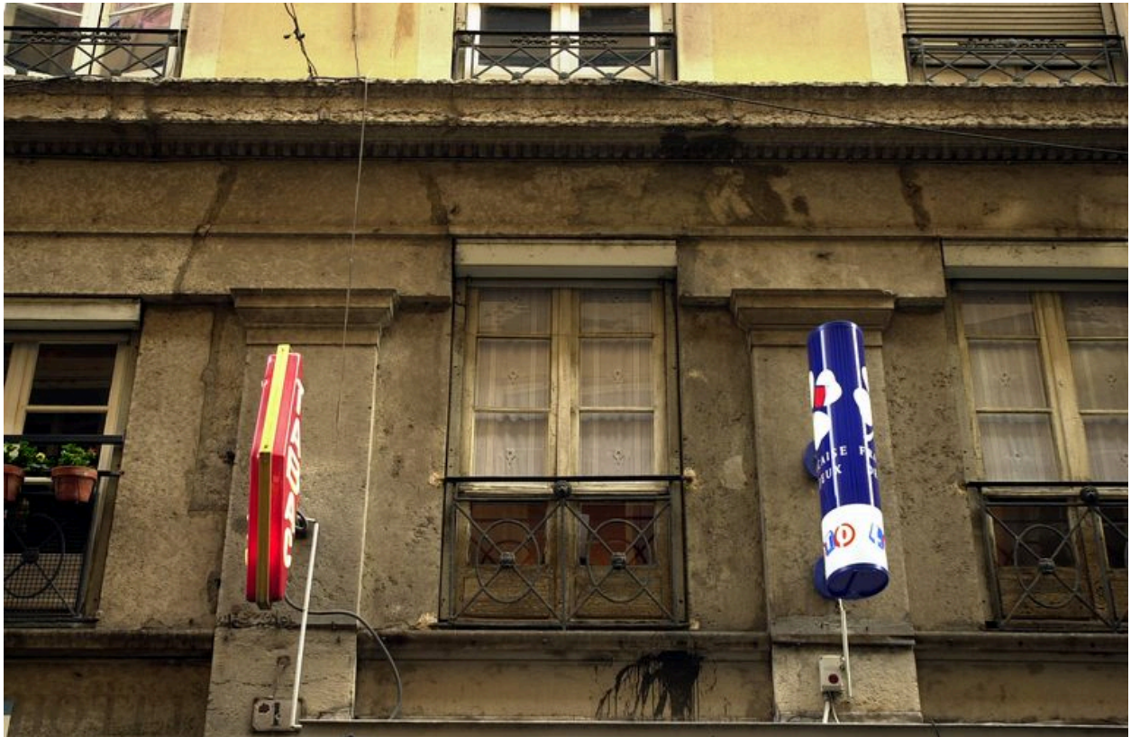
Elévation antérieure : détail du soubassement
