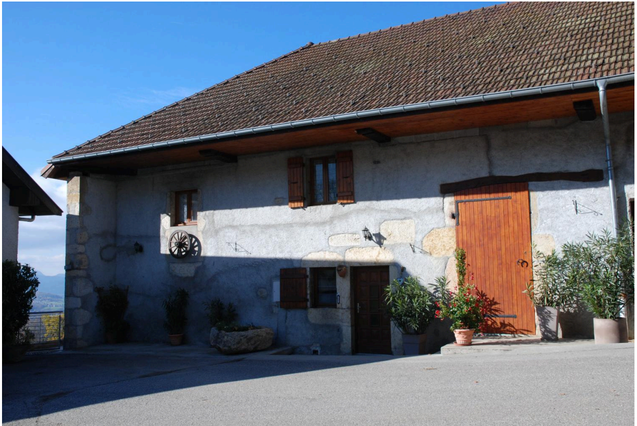
Vue de la ferme 2017 B2 2243, 2292 (non étudiée), partie habitation.
