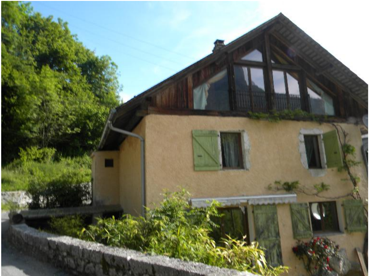
Vue du pignon sud d'une ancienne ferme (2008 B5 885,886).
