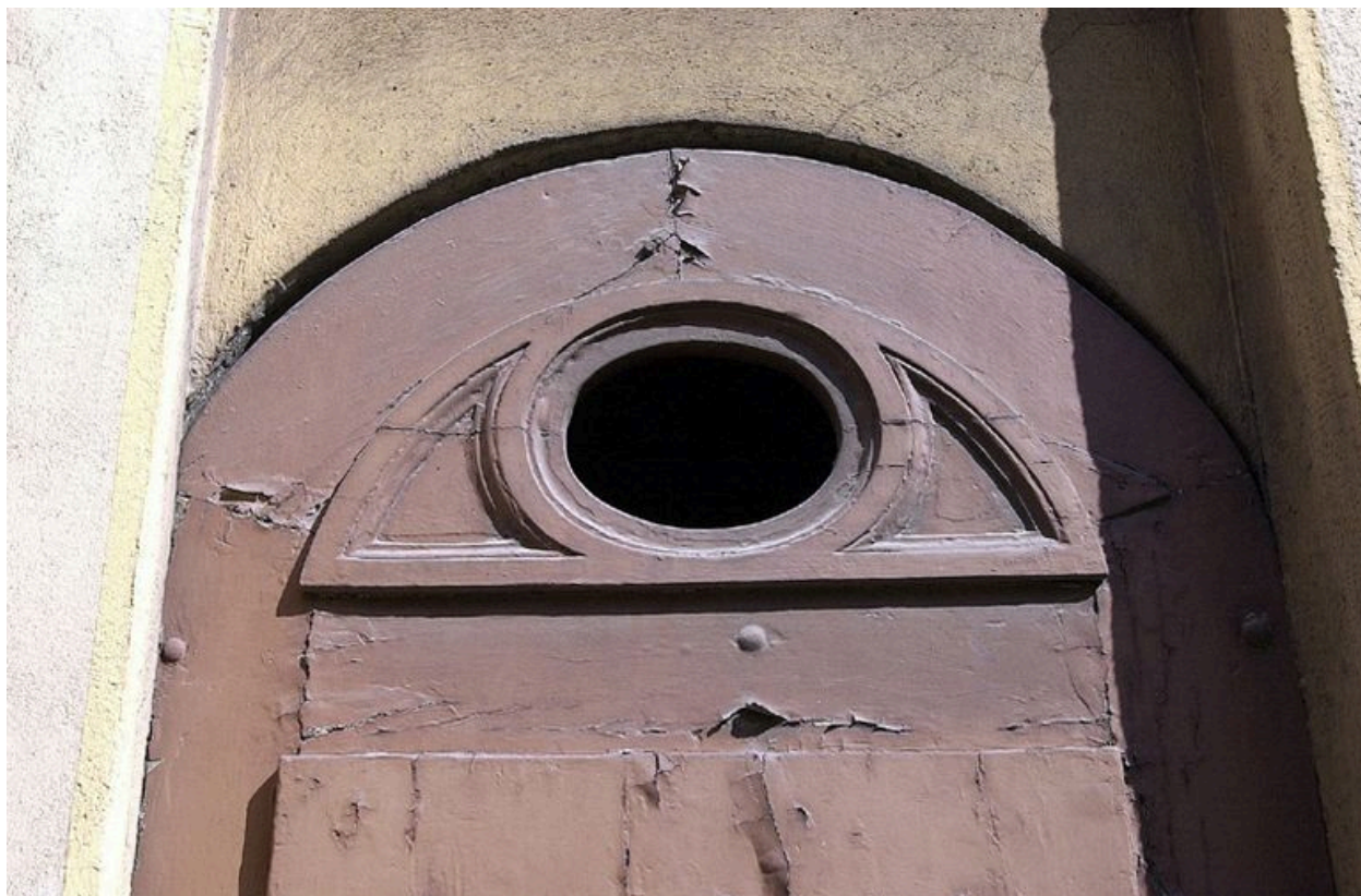
Détail de l'huissérie de la porte d'entrée
