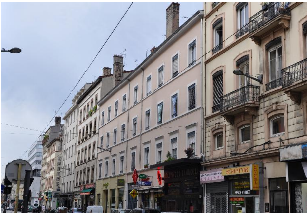
Vue d'ensemble de l'élévation sur rue
