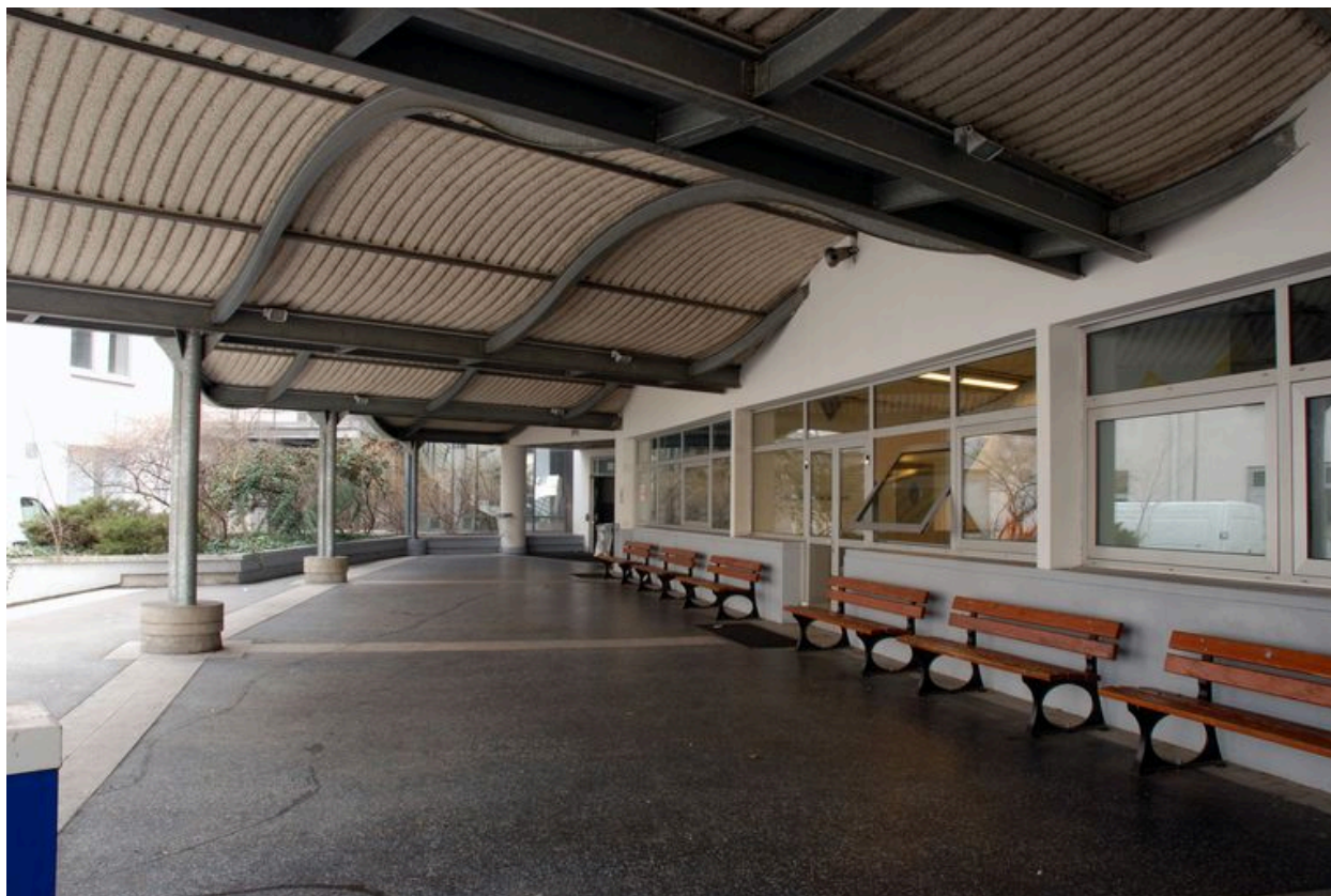
Bâtiment A : vue intérieure du préau
