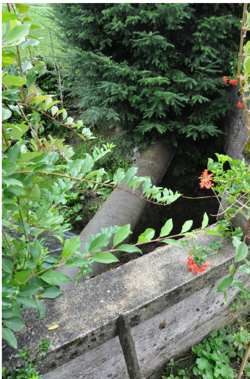
Vue de la conduite forcée après le pont de la route départementale n°58
