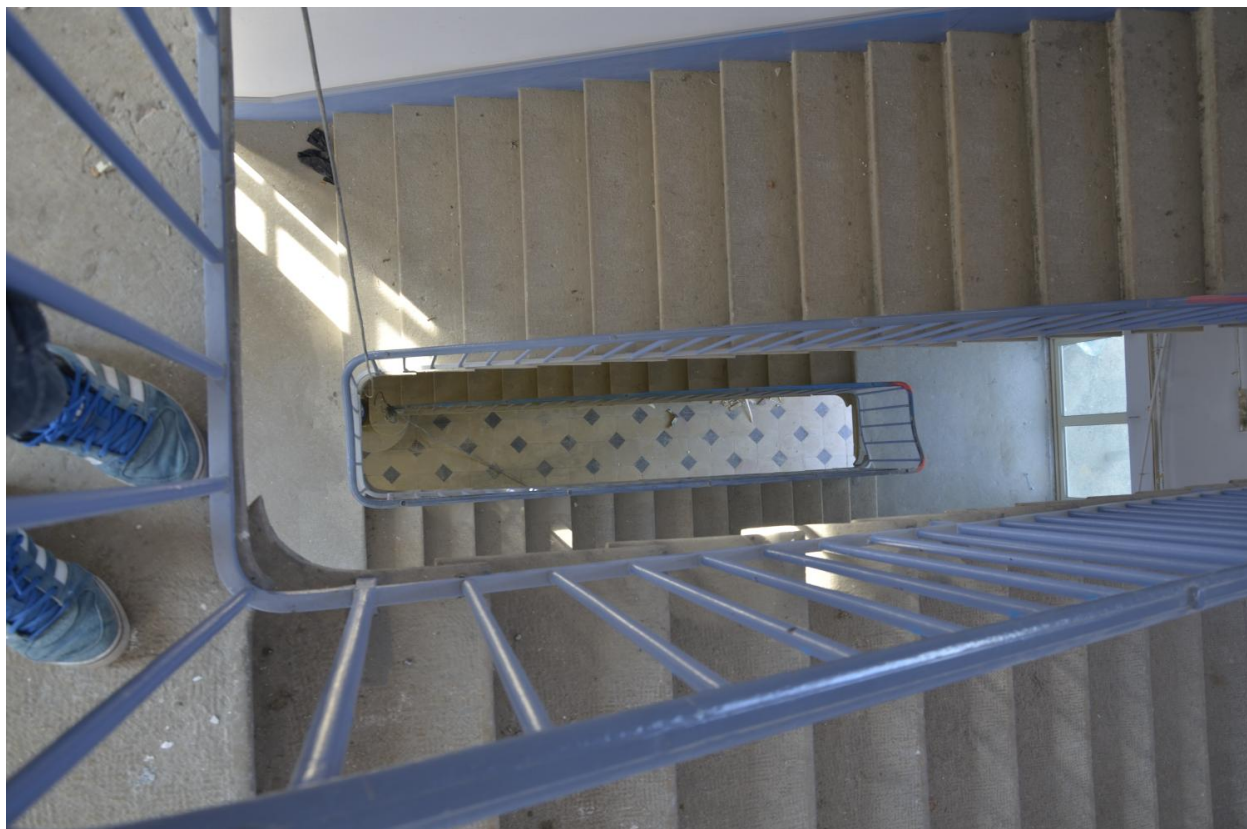
Petit lycée : cage de l'escalier principal (Phot. M. Poncin, A Lycée Lalande)
