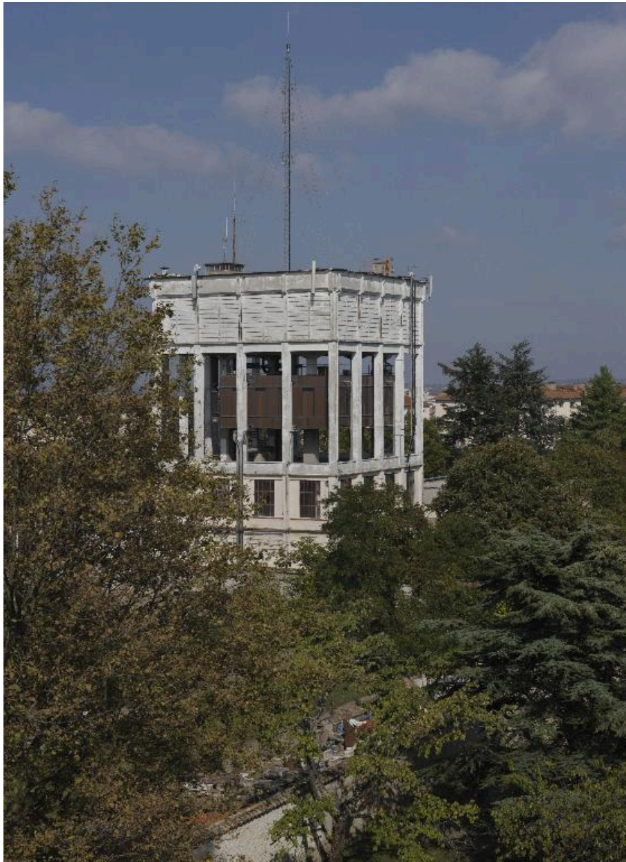
Vue d'ensemble du réservoir
