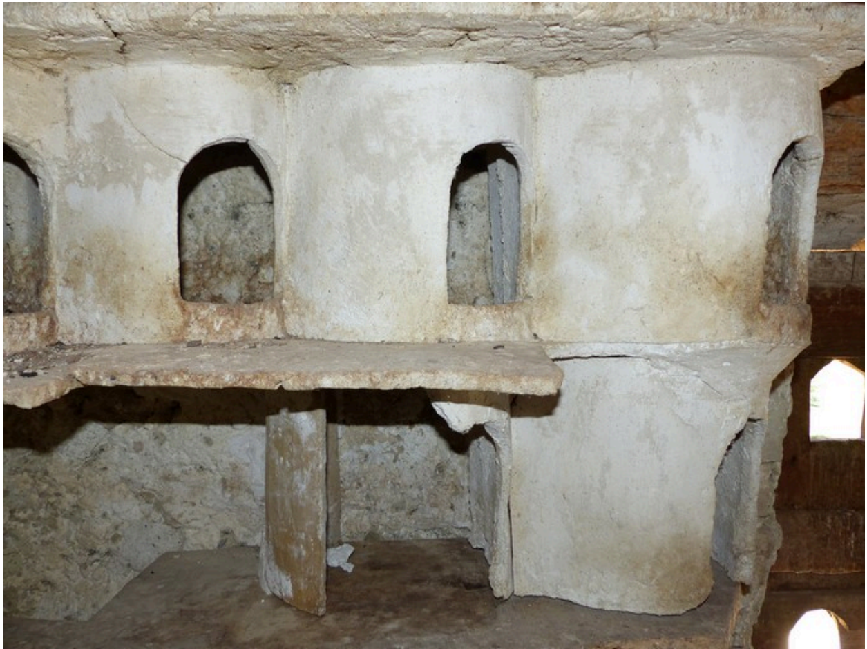
Rez-de-chaussée surélevé. Angle sud-est, boulins.
