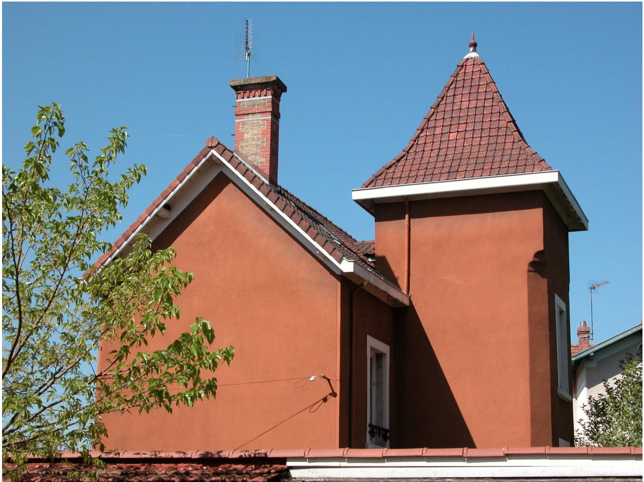
Vue rapprochée de la façade est
