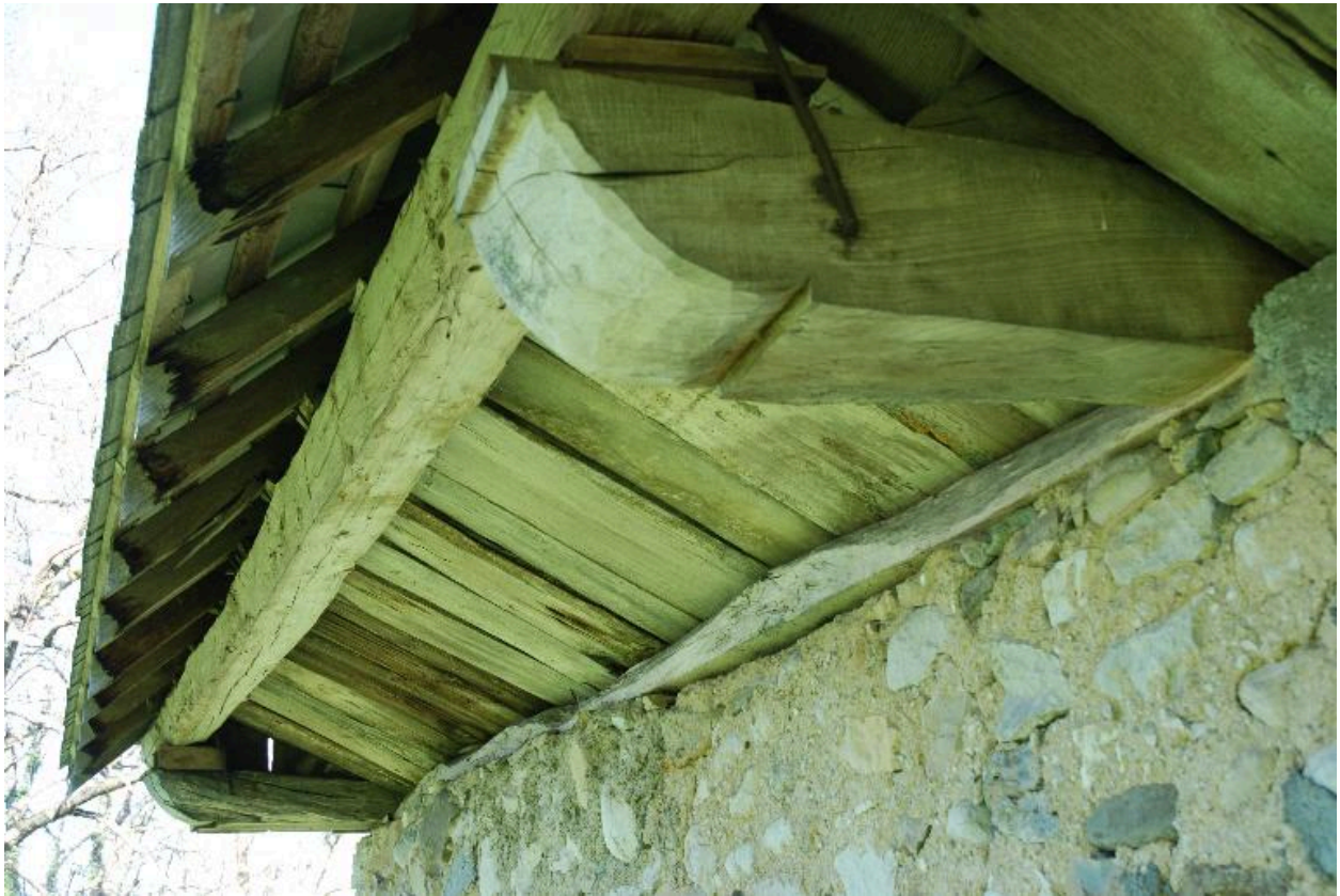
Détail de la fermeture de l'avant-toit.
